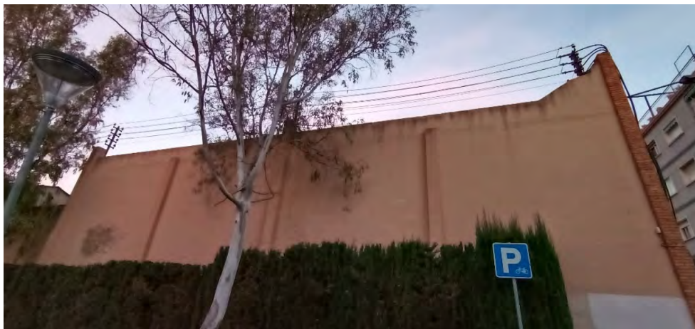
FAÇANA LATERAL ESQUERRA (COSTAT PARC)
