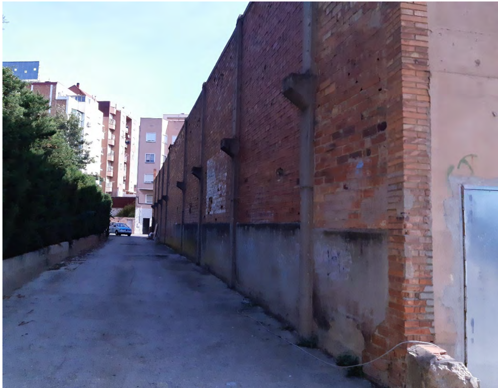
FAÇANA LATERAL DRETA
