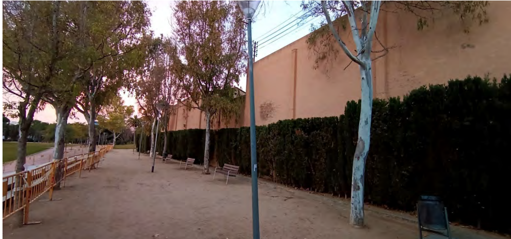
FAÇANA LATERAL ESQUERRA (COSTAT PARC)
