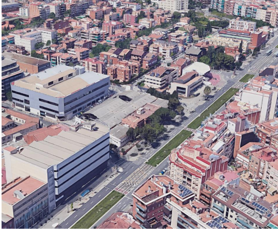
Vista del sector des de l'extrem oest, amb l'avinguda Cornellà en primer terme
