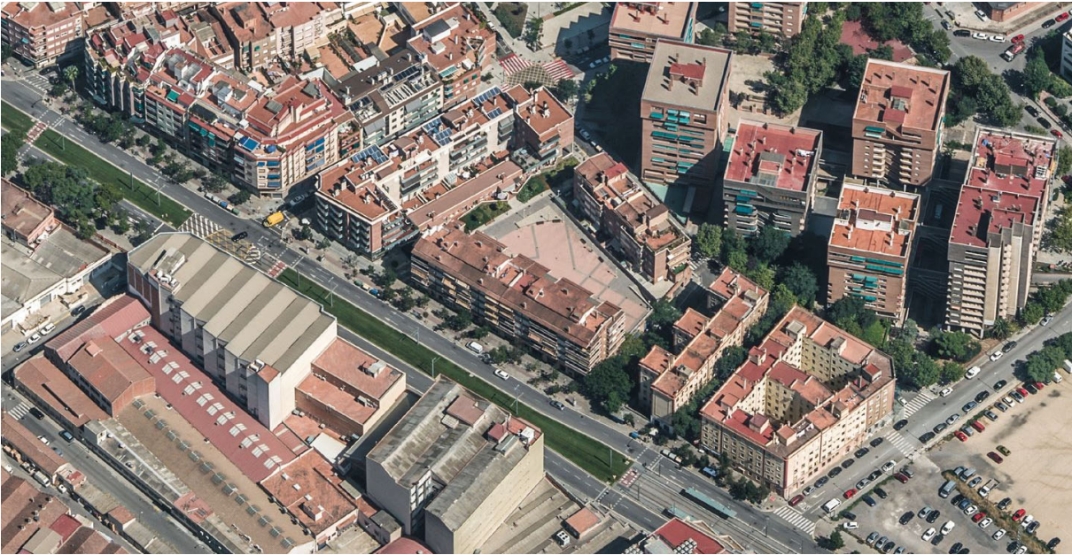
Façana sud de l'Avinguda de Cornellà. FONT: Google Maps
