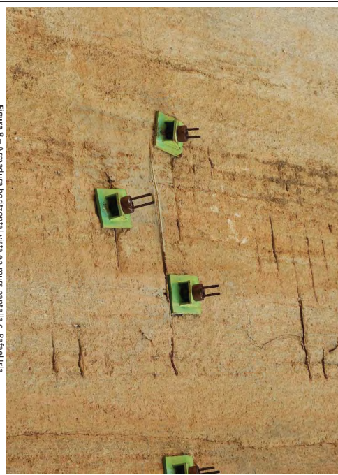
Figura 8 – Armadura horitzontal vista en murs pantalla C. Rafel·líria
