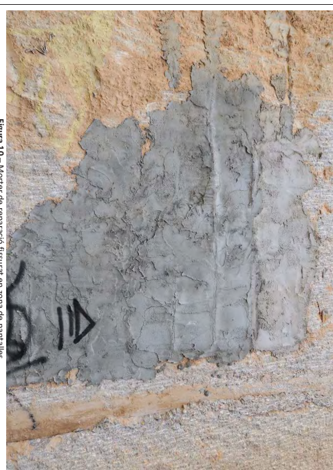
Figura 10 – Morter de reparació fissurat en zona de pantalles
