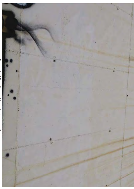
Figura 4 – Microfissuració vertical en mur 'B'
