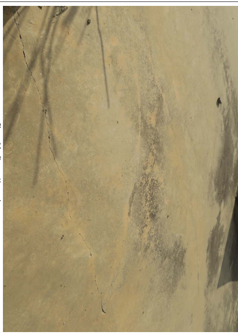
Figura 14 - Fisuració en soleres
