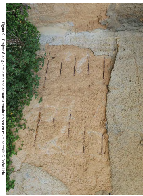
Figura 8 – Armadura horitzontal vista en murs pantalla C. Rafel·líria
