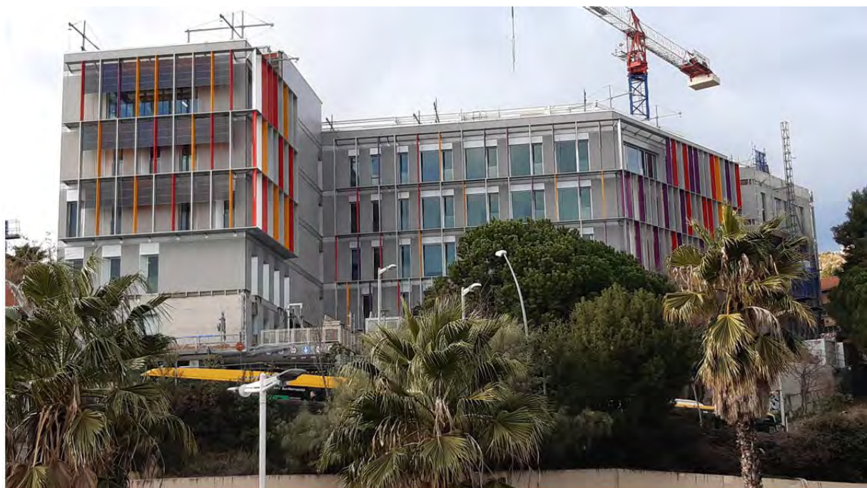
Façana sud-est del futur PCCB (estat actual estructura ampliació FASE1+2A)
