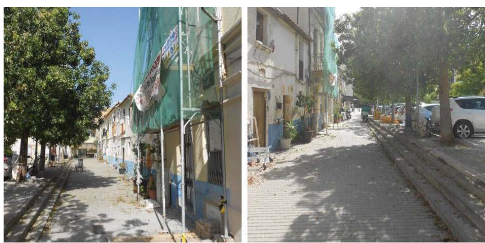
Urbanització carrer Sant Llorenç
