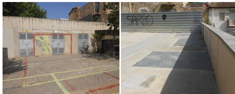
Vista Estació Transformadora
