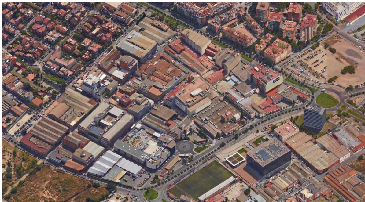
Vista aèria de l'àmbit de MPPGM des de l'Oest. Façanes avinguda del Baix Llobregat i carrer d'Àngel Guimerà
