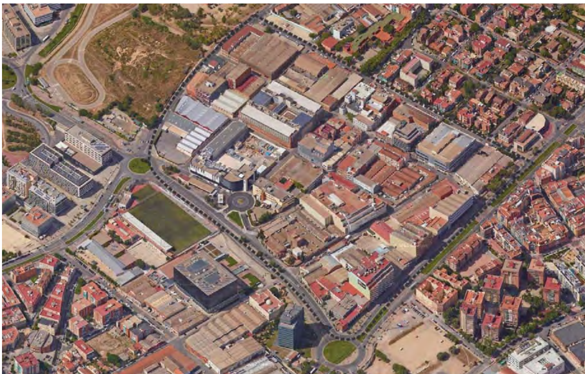
Vista aèria de l'àmbit de MPPGM des del Sud. Façanes avingudes del Baix Llobregat i de Cornellà
