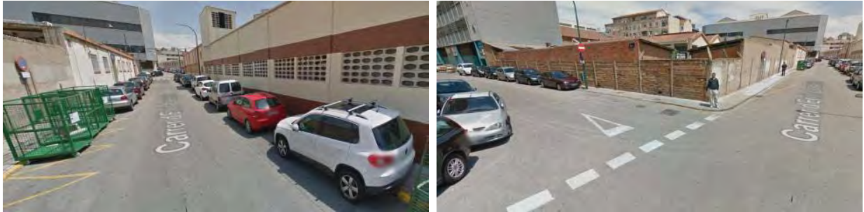
Figura 5. Estat actual de diversos carrers de l'àmbit del PAE del Gall
