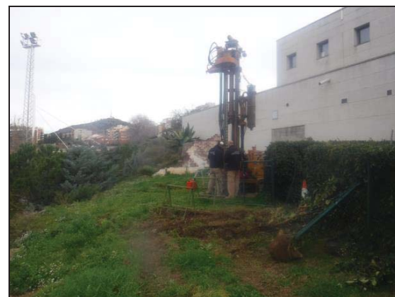
Máquina de sondeos en el sondeo S-4.
